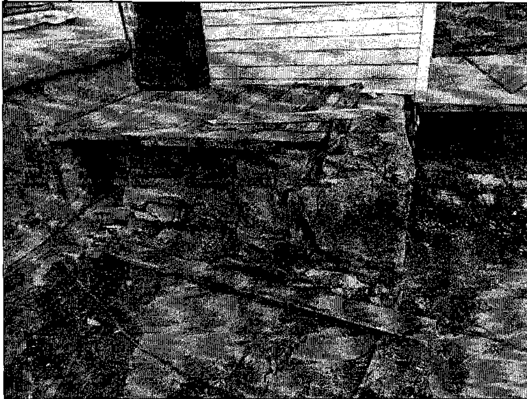
Фото 1, 2. Разрушение строительных конструкций крылец 1-го, 2-го, 3-го, 4-го подъездов и крыльца пристройки (помещения адвокатуры).
