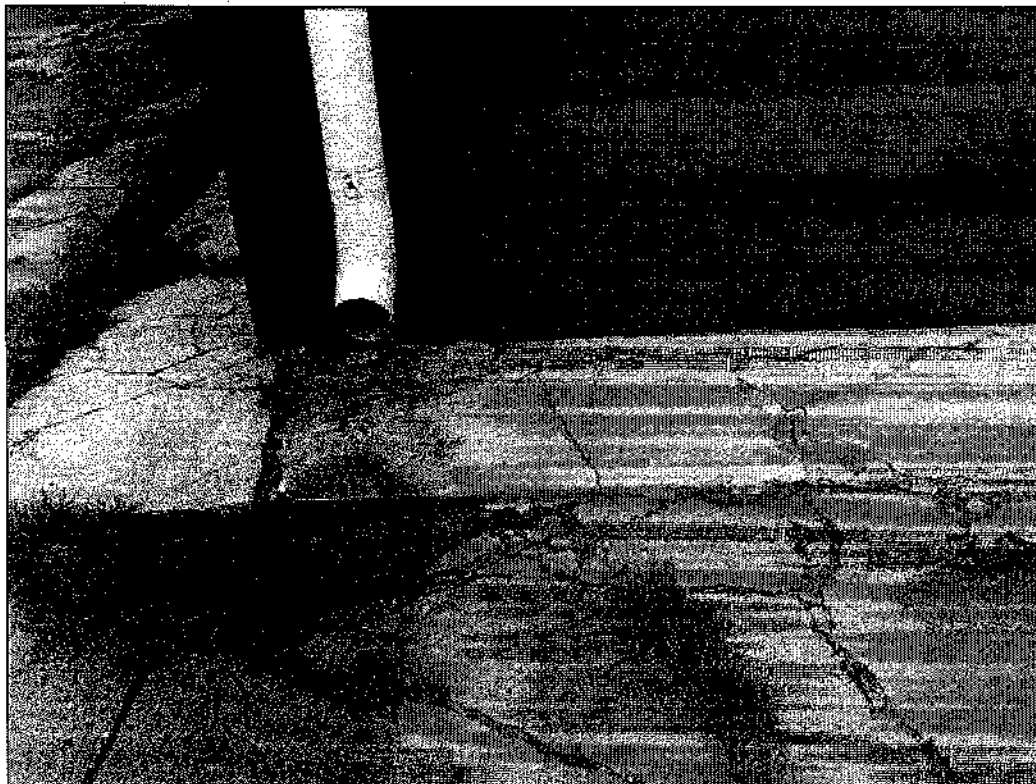
Фото 3, 4. Разрушение отмостки по периметру здания.
