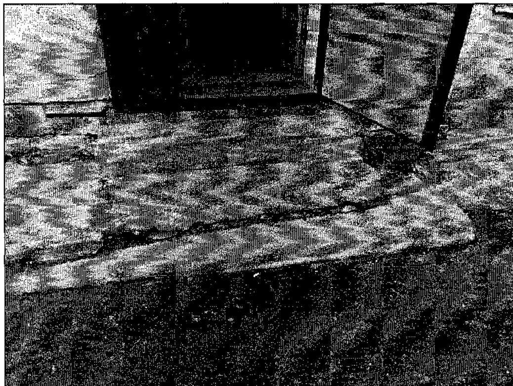
Фото 1, 2. Разрушение строительных конструкций крылец 1-го, 2-го, 3-го, 4-го подъездов и крыльца пристройки (помещения адвокатуры).
